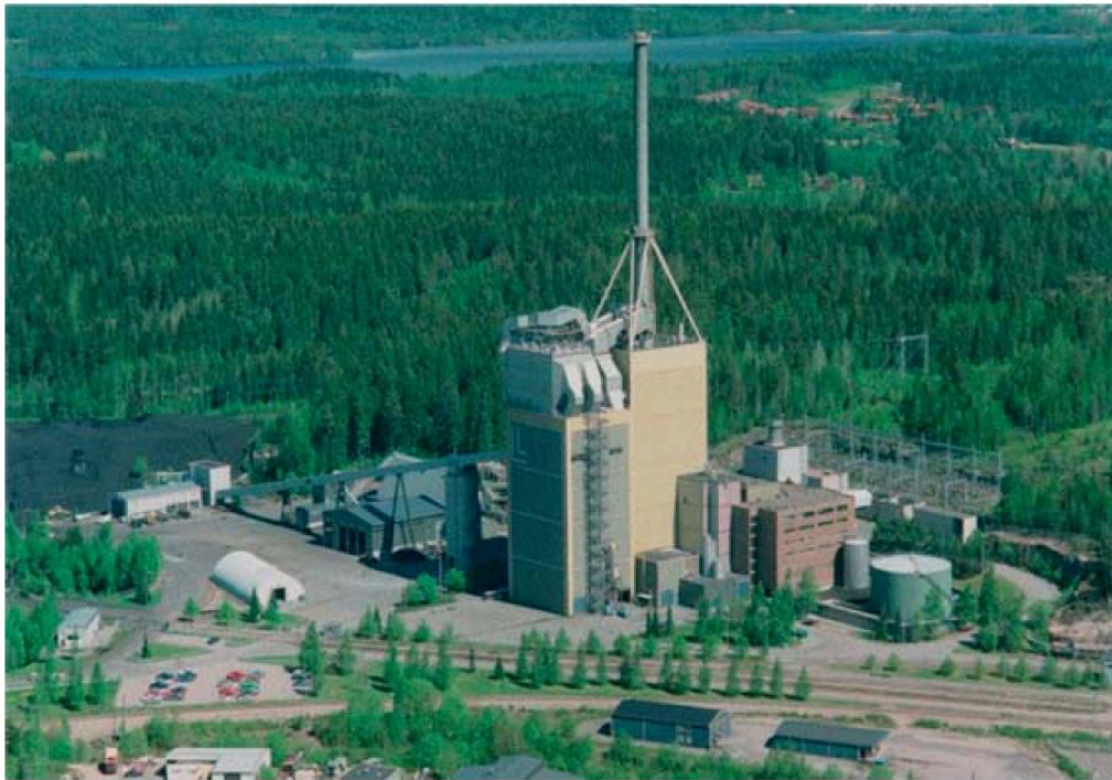
Kuva 1.1 Yleisnäkö Kymijärven voimalaitokselta
